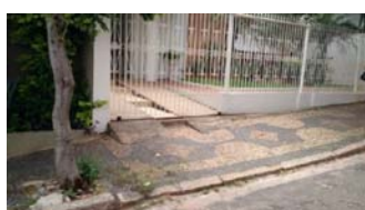
Fig. 10 Quadra 2: Rampa de garagem inadequada
