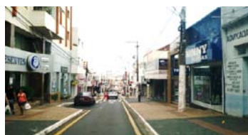
Fig. 15 Quadra 11 e 12: Ausência de sinalização tátil
