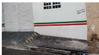
Fig. 7 Quadra 31: Desnível para acesso de veículos
