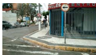
Fig. 11 Quadra 3: Inexistência de rebaixamento de guia
