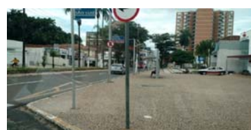
Fig. 12 Quadra 5: Inexistência de rebaixamento de guia
